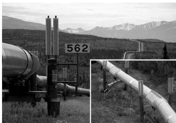
Рис. 1. Последствия землетрясения 7.9 баллов на магистрали Trans-Alaska Pipeline System
